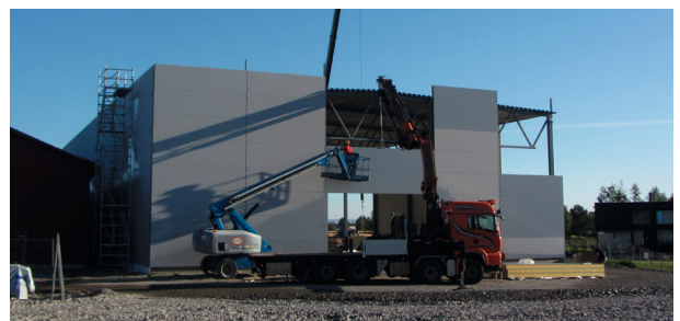
Ny trelasthall på Lindstad tar form. Foto Jørn H. Sørli
