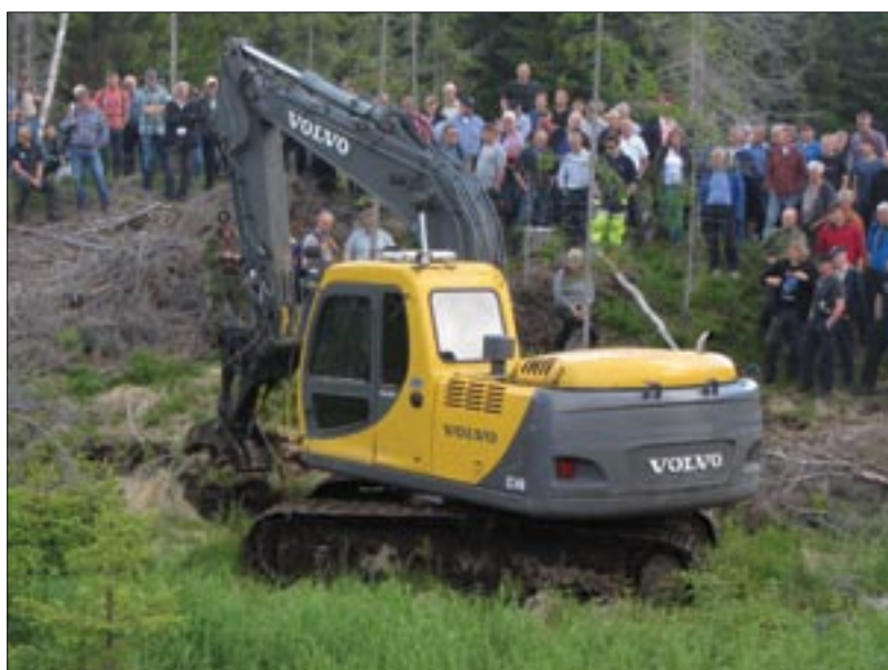
Markberedning med Karl-Oskar aggregat på bruksrettsbefaringen.
