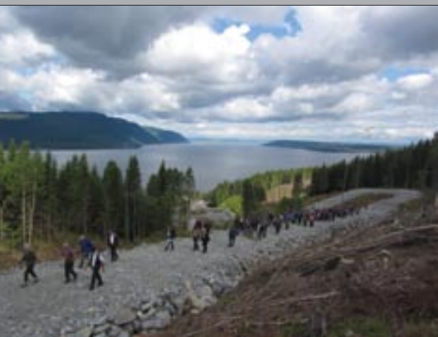
Fra bruksrettsbefaringen - mudderdeponi og vegbygging i Frangseterberget.
