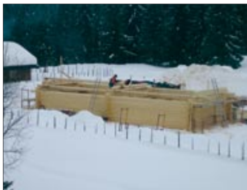
Lafting av nytt seterhus på Bringebu i Vang. Foto: Jørn Harald Sørli.
