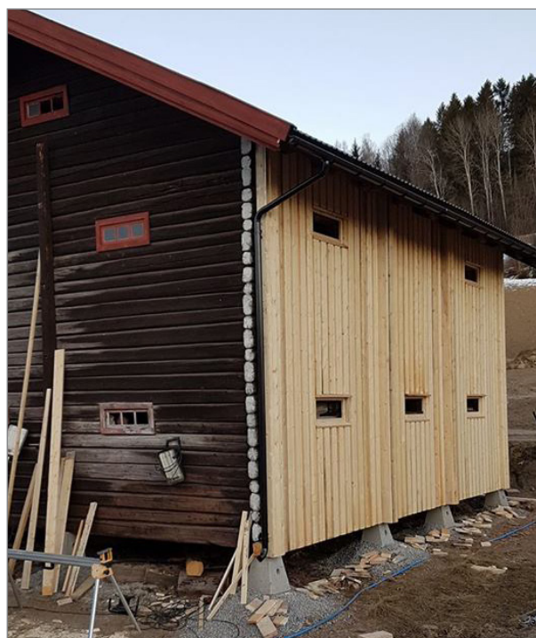
Restaurering på Vethammaren. Foto: Bjørn Ramseth
