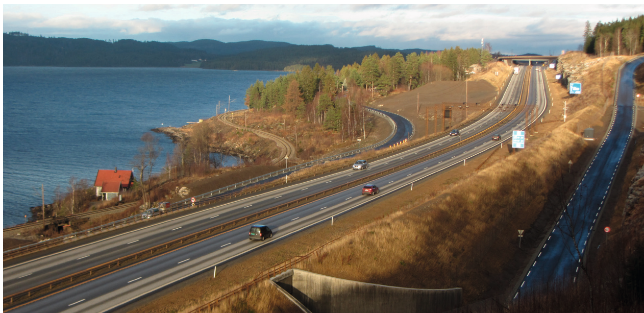
E6-utbyggingen langs Mjøsa endelig ferdig. Foto: Jørn H. Sørli
