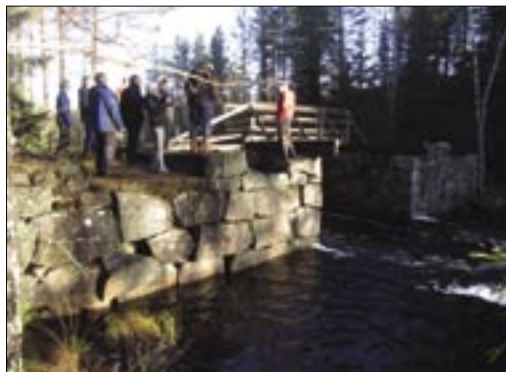
Befaring av restaureringsobjekt - dammer og bruer. Foto Rune O. Brenna.
